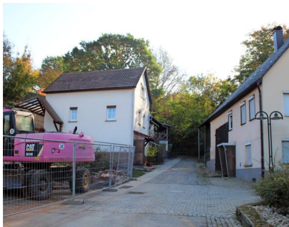
Die Gottlieb-Härle-Straße endet in einem Hohlweg ohne Wendemöglichkeit. Das rechte Haus soll abgerissen werden.
